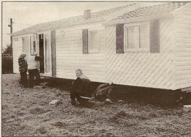
L'installation des mobile homes se poursuit à un rythme soutenu au terrain de camping des Alleux.
